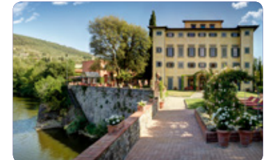
Villa La Massa Chiara Della Bosca +39 031 348890 chiara.dellabosca@villadeste.it Florence / GDS - LW
